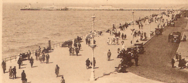
Vue générale de la Digue vers l'estacade.
